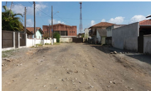
Figura 8: Trecho experimental executado com ADF.
