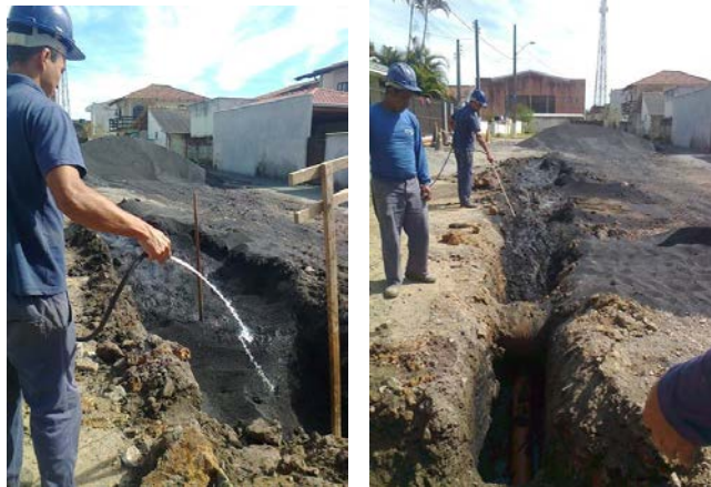
Figura 7: Reaterro de vala com adensamento hidráulico.
