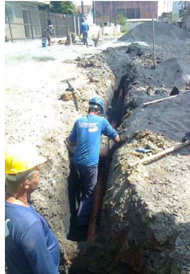
Figura 6: Assentamento da Tubulação.
