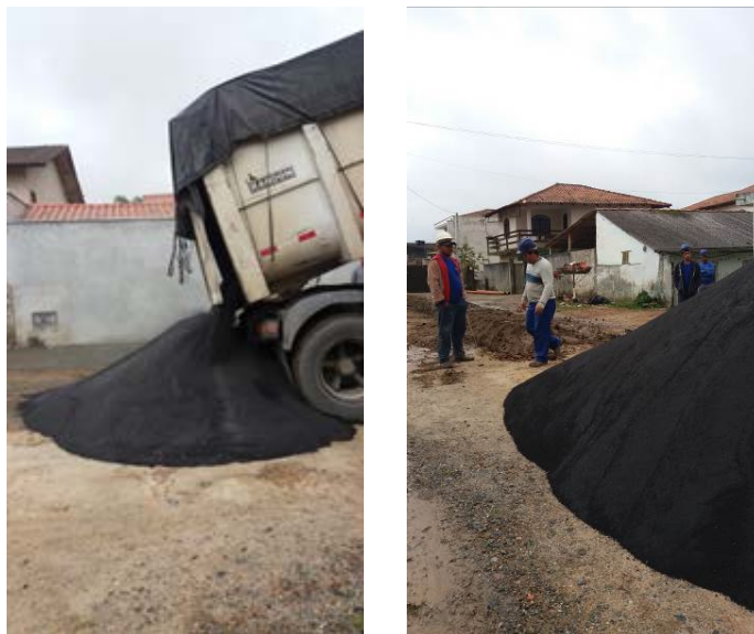
Figura 4: Entrega da ADF na obra.
